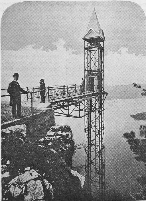
Abb. 3. Obere Plattform und Zugangssteg.
