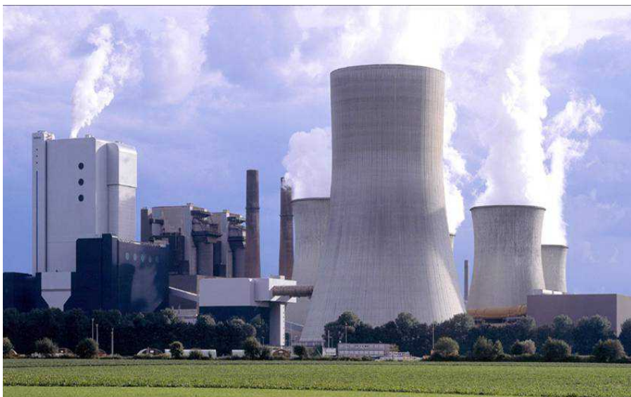
После вывода из работы
