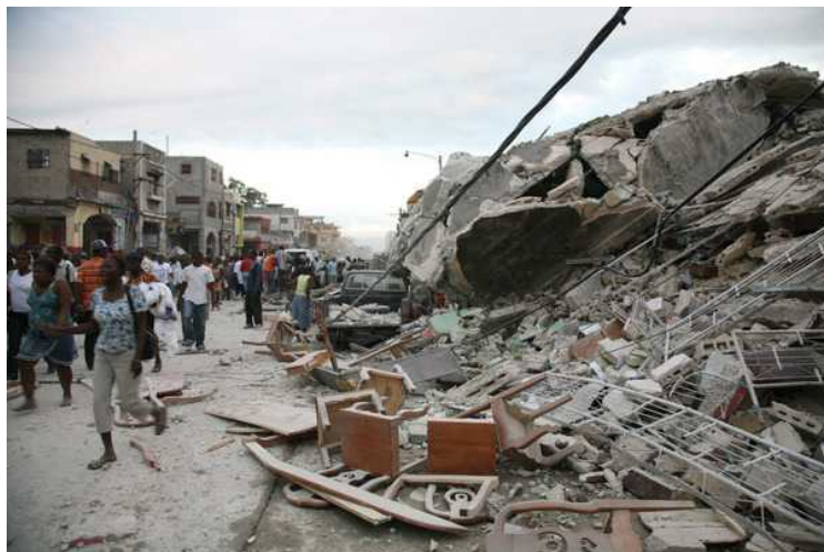
Дома, разрушенные землетрясением на Гаити (batiweb.com)
