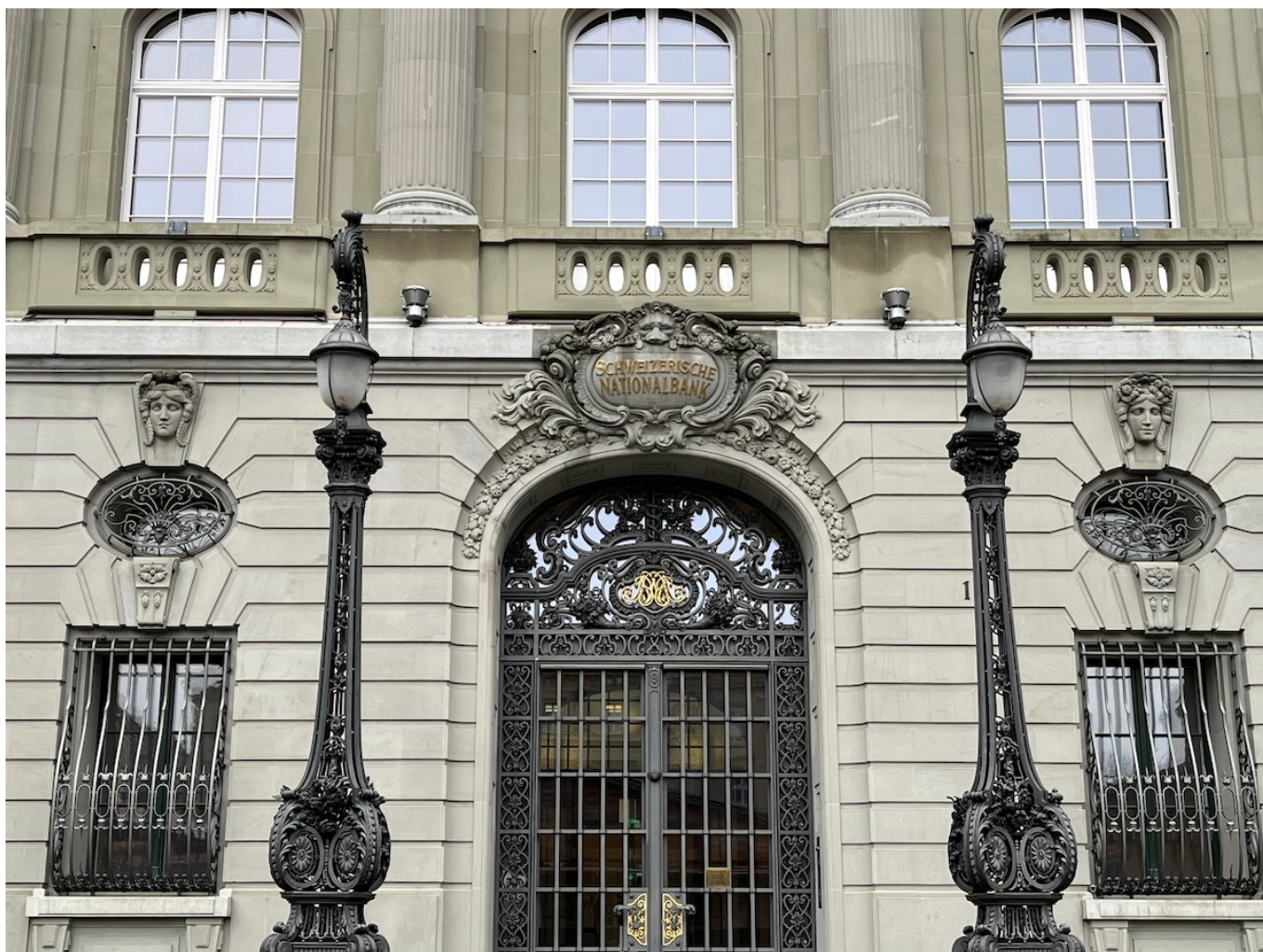
Здание Нацбанка в Берне. Фото: Nashagazeta.ch
