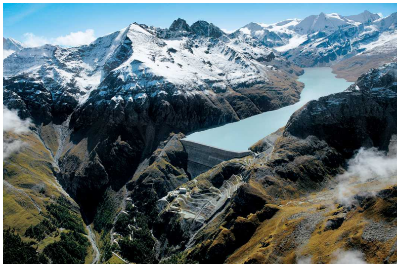
Гидрокомплекс Клезон-Диксенс ( grande-dixence.ch )
