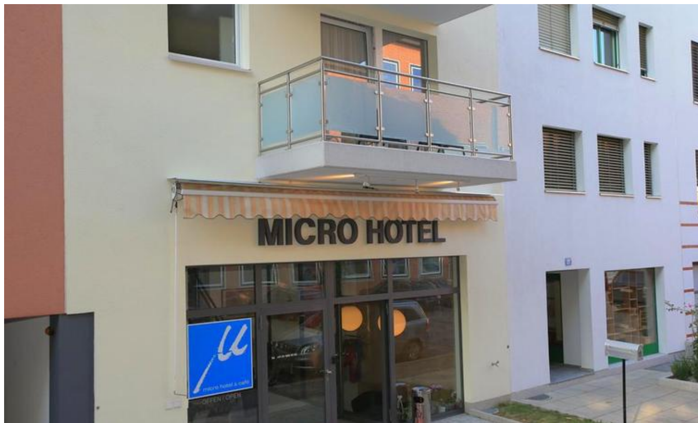
Базельский Micro Hotel (corner.stnet.ch)
