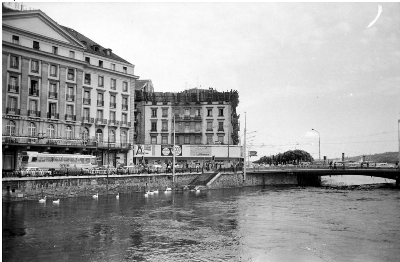
Работы по сносу отеля, 21 июня 1969 г. Bibliothèque de Genève.
