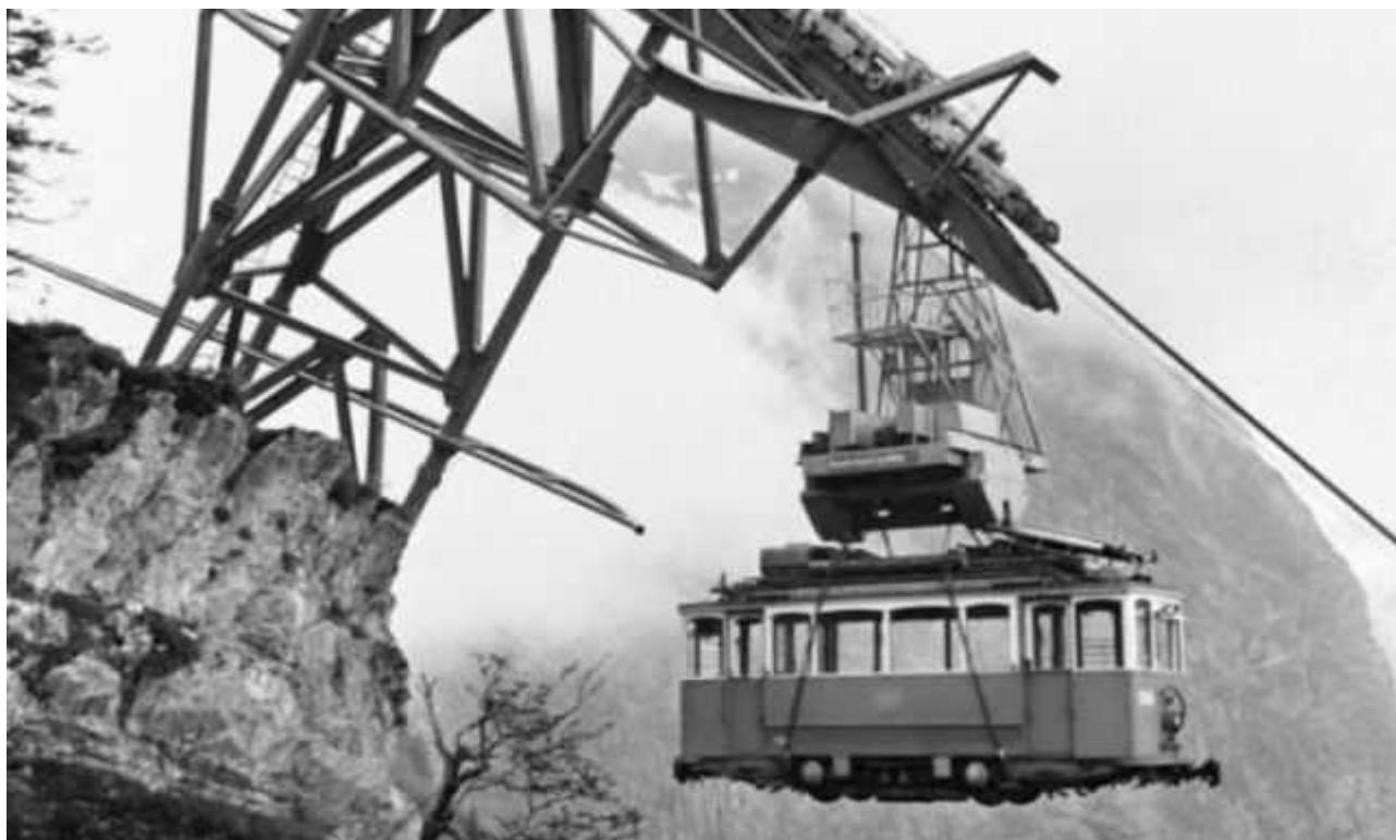
Так трамваи поднимались по канатной дороге к новому месту работы (© Keystone) В 1960-е годы на стройке века в Швейцарских Альпах, сооружении электростанции Линт-Лиммерн, использовались трамваи. Их подняли на почти двухсотметровую высоту при помощи канатной дороги, а по завершении строительства... потеряли где-то в горах. Швейцарский историк заинтересовался их судьбой.
