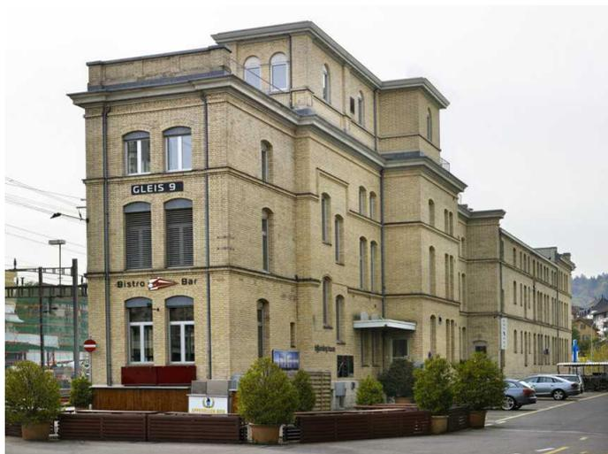
122-летний свидетель промышленного расцвета Орликона (Keystone) Элегантная форма, высота четыре этажа, длина 80 метров, ширина 12 метров – такая машина была поставлена на стальные рельсы и, под действием гидравлического пресса, двинулась со средней скоростью 4 метра в час на новое место, на 60 метров дальше, чем оно располагалось у вокзала в местечке Орликон. Зданий такого размера никогда прежде не передвигали ни в Швейцарии, ни во всей Европе!
