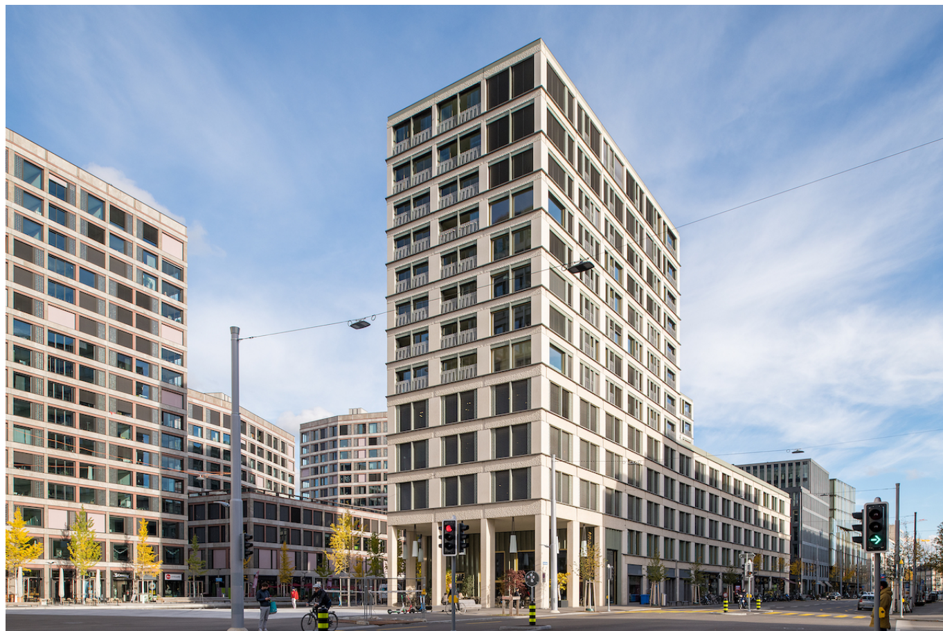
Башня на Europaallee © Stadt Zurich
