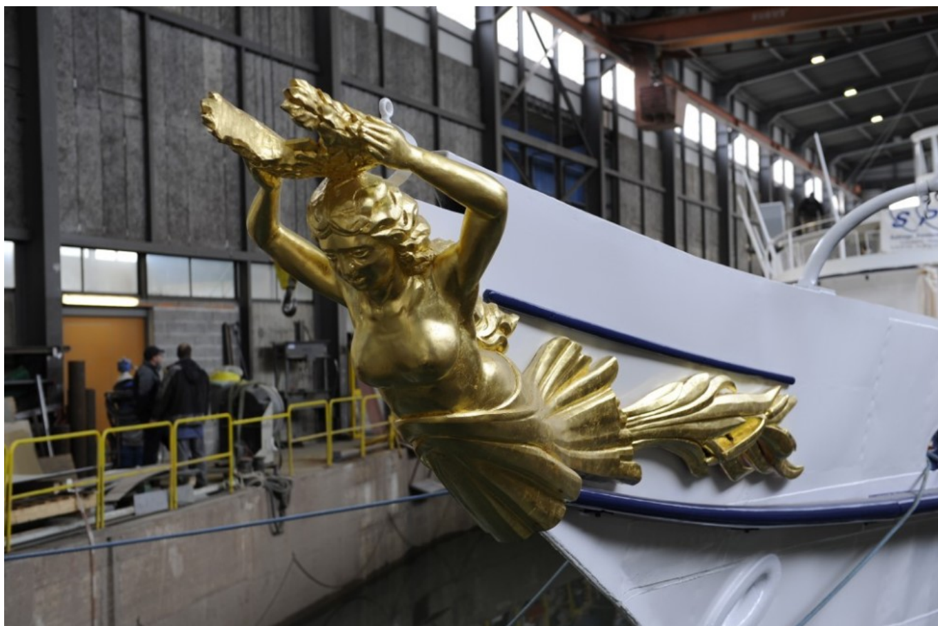
Ремонтные работы на пароходе «Suisse» (abvl.ch)
