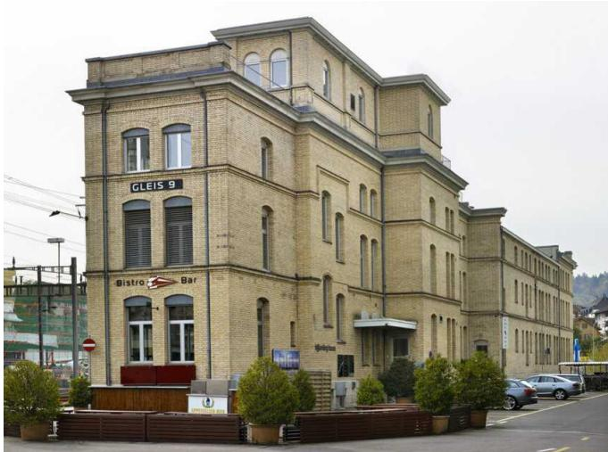
Элегантная форма, высота четыре этажа, длина 80 метров, ширина 12 метров – такая машина была поставлена на стальные рельсы и, под действием гидравлического пресса, двинулась со средней скоростью 4 метра в час на новое место, на 60 метров дальше, чем оно располагалось у вокзала в местечке Орликон. Зданий такого размера никогда прежде не передвигали ни в Швейцарии, ни во всей Европе!
