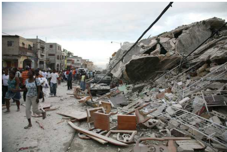
Дома, разрушенные землетрясением на Гаити (batiweb.com)
