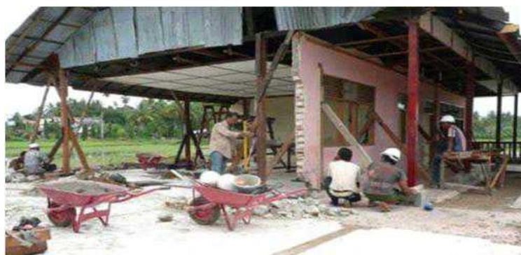
Восстановление школы в Паданге (Индонезия), пострадавшем от землетрясения в сентябре 2009 года (© Architectes de l'Urgence)
