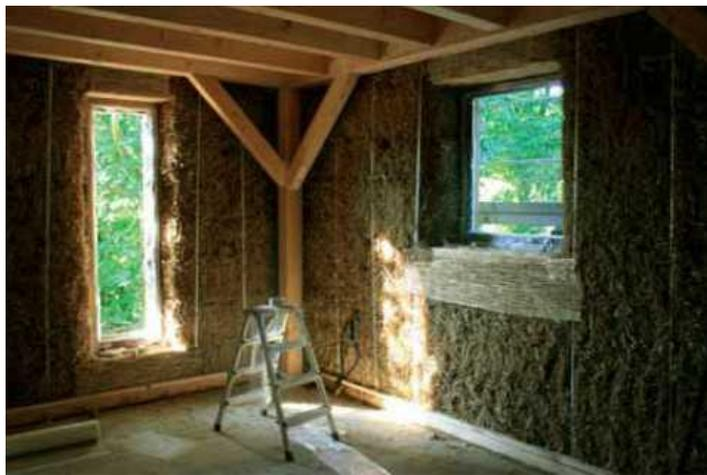
Соломенные дома ничуть не холоднее своих бетонных или деревянных собратьев, ведь плотный стог сена – удивительный изолятор, к тому же, позволяющий строению «дышать». Так что зимой стены из соломы сохраняют тепло без дополнительного обогрева, а летом не накаляются, в отличие от искусственных материалов. Стоит ли говорить об экологическом значении соломенного дома – его незначительном влиянии на окружающую среду и исключительно малых выбросах парниковых газов при эксплуатации?
