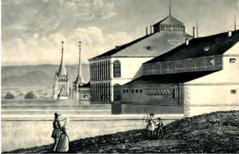
Исправительный дом Бетюзи, Лозанна, 1830 (lausanne.ch)
